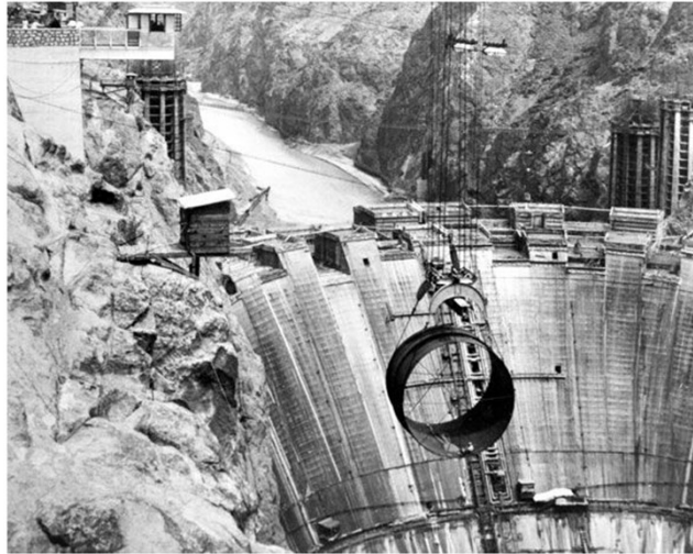
Construction du barrage Hoover
